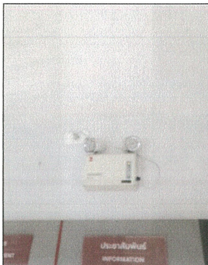
รูปภาพที่ 2.22 ไฟสำรองฉุกเฉิน
